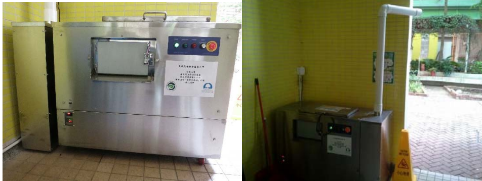
位於 1 號梯旁的廚餘機
